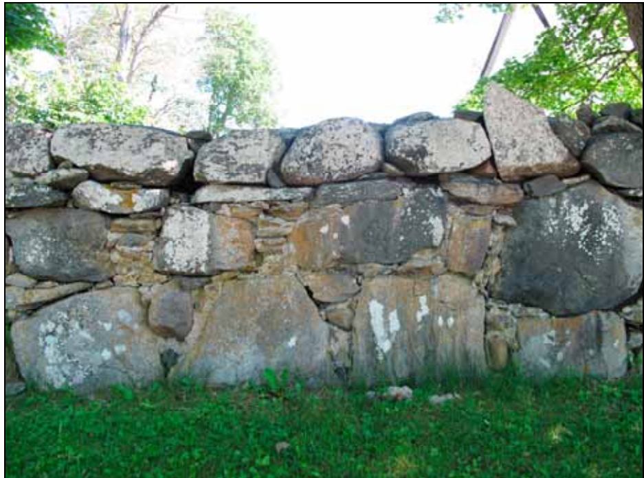
Medeltida varmmur med ett skikt stenar från 1797 års läggning i södra bogårdsmuren. Foto: Lisa Sundström, bildnr: lp20100366.
