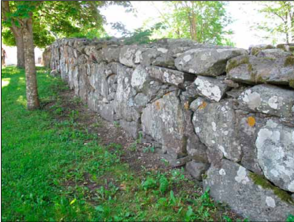
Punkt 9. Efter reparation av murens insida. Foto: Lisa Sundström, bildnr: lp20100363.
