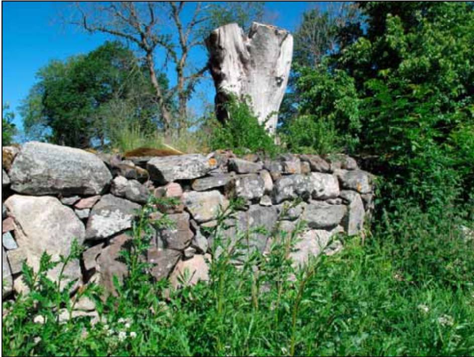
Punkt 6 efter reparation av murens utsida. Foto: Lisa Sundström, bildnr: lp20100357.
