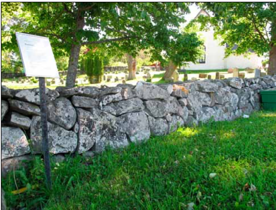
Punkt 10 efter omläggning av mur. Foto: Lisa Sundström, bildnr: lp20100364.
