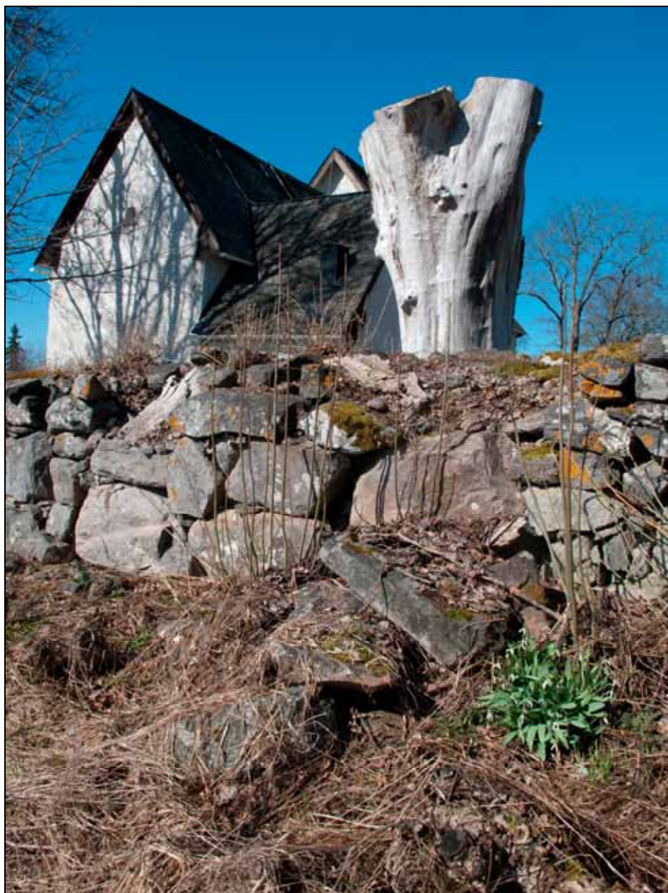
Punkt 6. Raserad mur före reparation. Foto: Lisa Sundström, bildnr: lp20100356.
