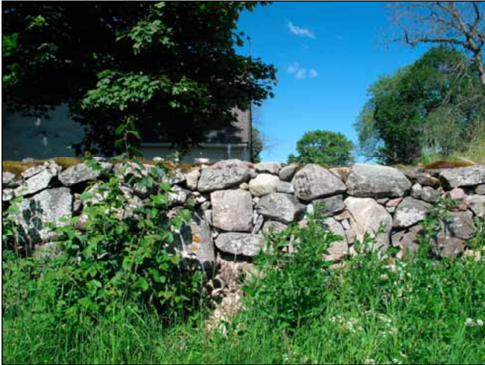
Punkt 7 efter reparation av murens utsida. Foto: Lisa Sundström, bildnr: lp20100359.
