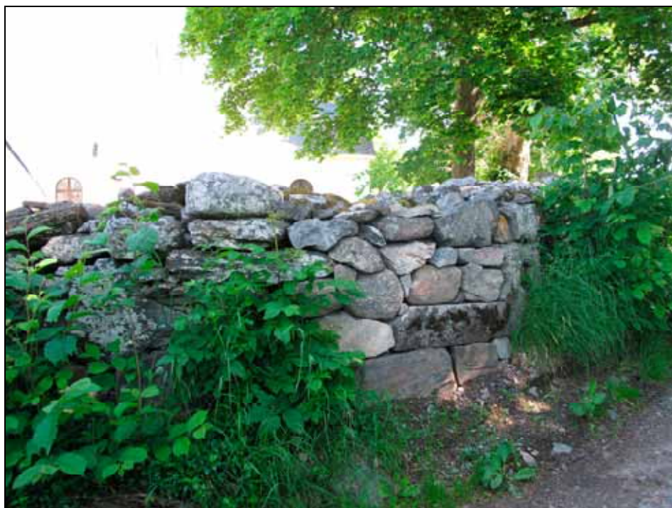
Punkt 8 efter reparation av murens utsida. Foto: Lisa Sundström, bildnr: lp20100361.
