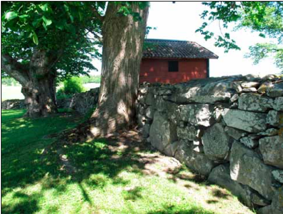
Punkt 1 och 2 efter återuppläggning av murens insida. Foto: Lisa Sundström, bildnr: lp20100350.
