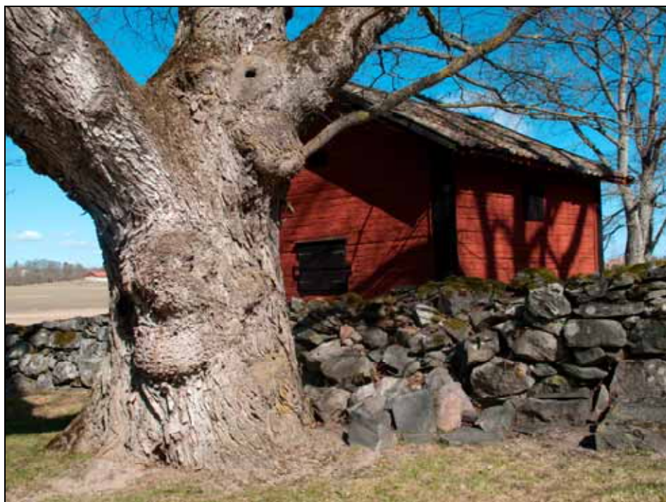
Punkt 1. Raserad mur före återuppläggning av murens insida. Foto: Lisa Sundström, bildnr: lp20100348.
