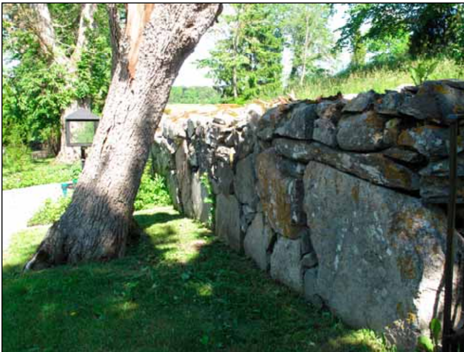
Punkt 5 efter reparation av murens insida. Foto: Lisa Sundström, bildnr: lp20100355.
