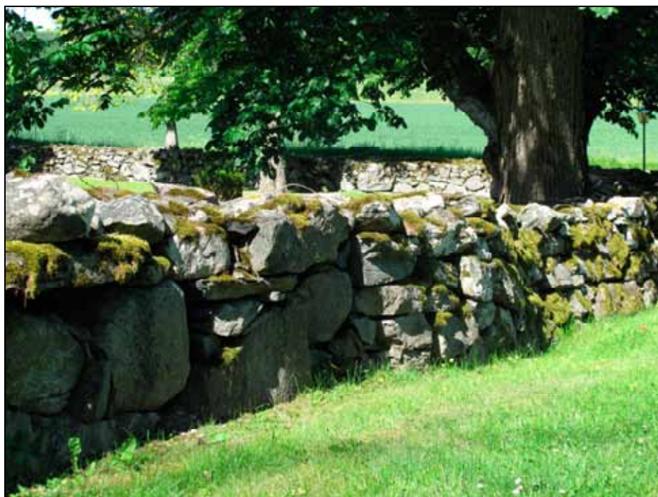
Punkt 3 efter reparation av murens utsida. Foto: Lisa Sundström, bildnr: lp20100352.
