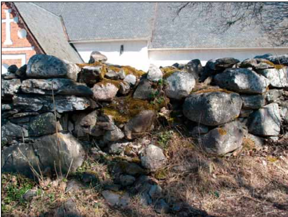
Punkt 8 före reparation. Foto: Lisa Sundström, bildnr: lp20100360.
