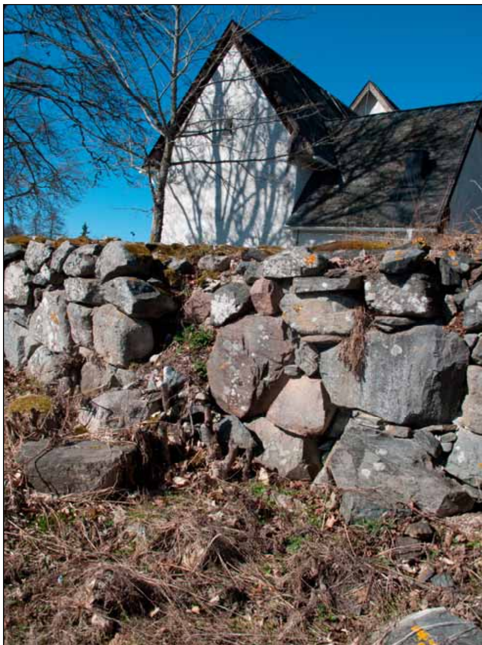
Punkt 7. Raserad mur före reparation. Foto: Lisa Sundström, bildnr: lp20100358.
