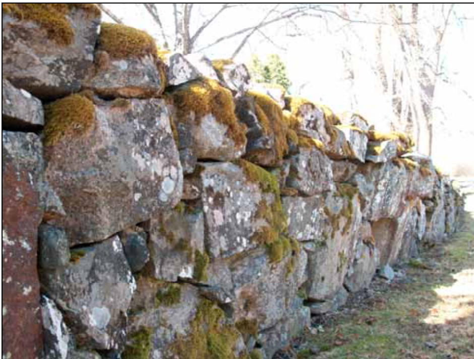
Punkt 3 före reparation av murens utsida. Foto: Lisa Sundström, bildnr: lp20100351.
