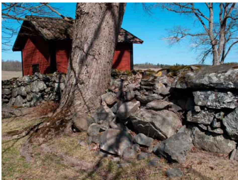
Punkt 2. Raserad mur före återuppläggning av murens insida. Foto: Lisa Sundström, bildnr: lp20100349.
