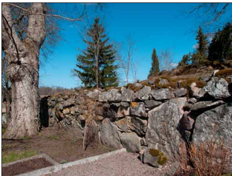
Punkt 4. Raserad sten före reparation. Foto: Lisa Sundström, bildnr: lp20100353.
