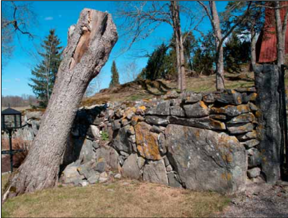
Punkt 5. Raserad mur före reparation. Foto: Lisa Sundström, bildnr: lp20100354.
